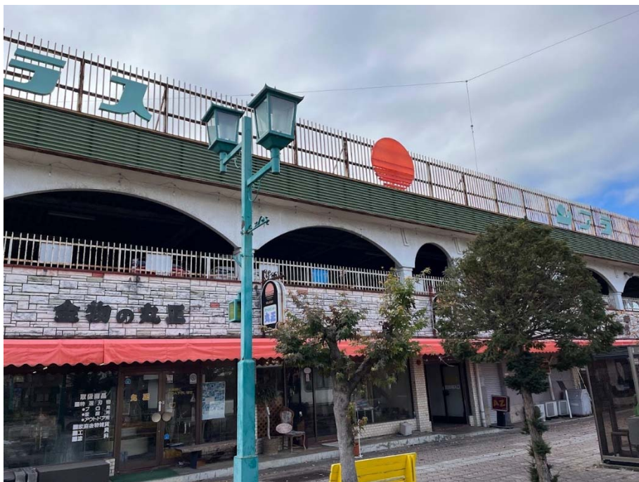
図表 3.2.4 中込商店街の建物群
