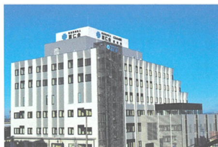
平成29年より中込駅前に新築移転したくろさわ病院
