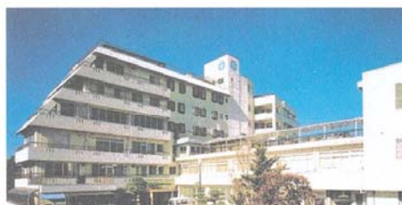
昭和63年病院建物増築時（介護老人保健施設安寿苑開設）の建物全景
