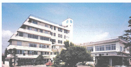
昭和54年病院建物高層化集合住宅完成時の建物全景
