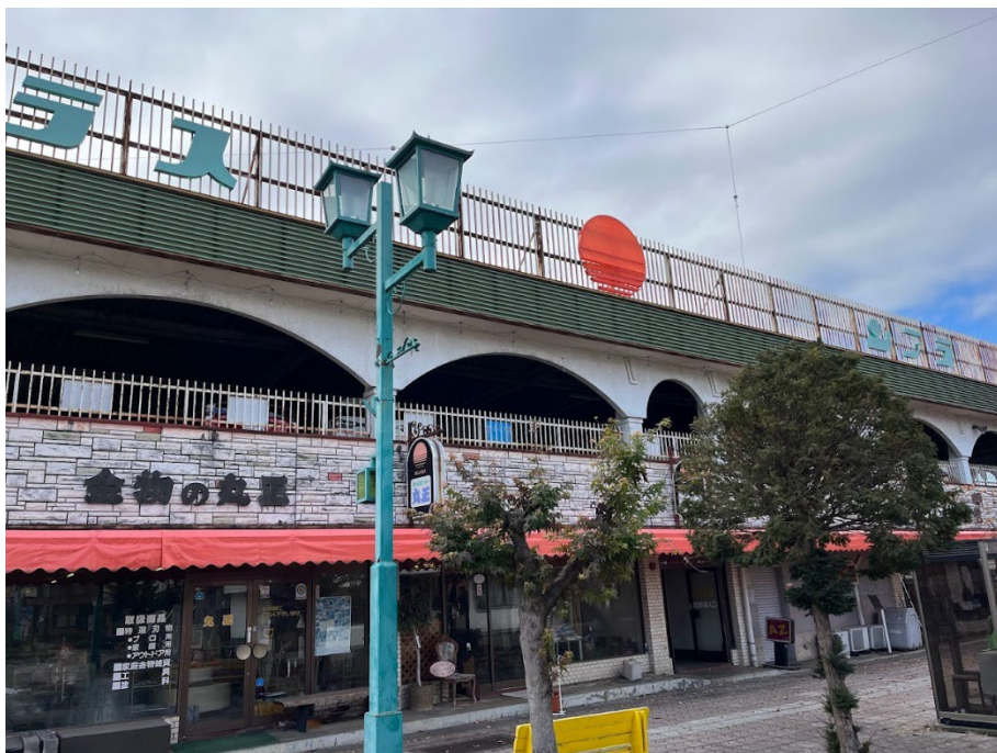
図表 3.2.4 中込商店街の建物群
