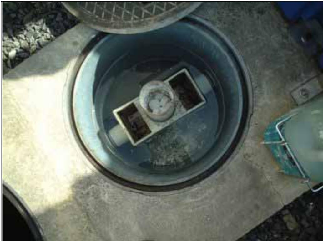
注：ある総合病院の殺菌処理槽を筆者が撮影。中和された排水が固体の次亜塩素酸カルシウムの置かれている中を通過する仕組み。このあと、希釈されずに直接、公共下水道に放流されている。
