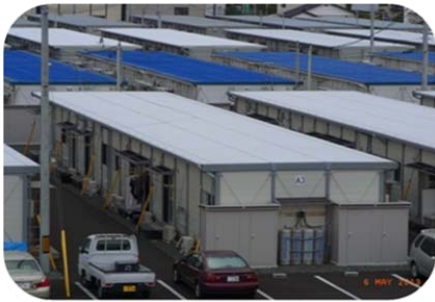
いわき市の仮設住宅
